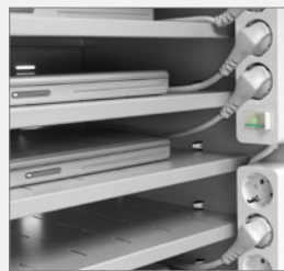
Organización eléctrica con regletas de 6 tomas
