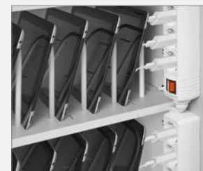
Organización eléctrica con regletas de 6 tomas
